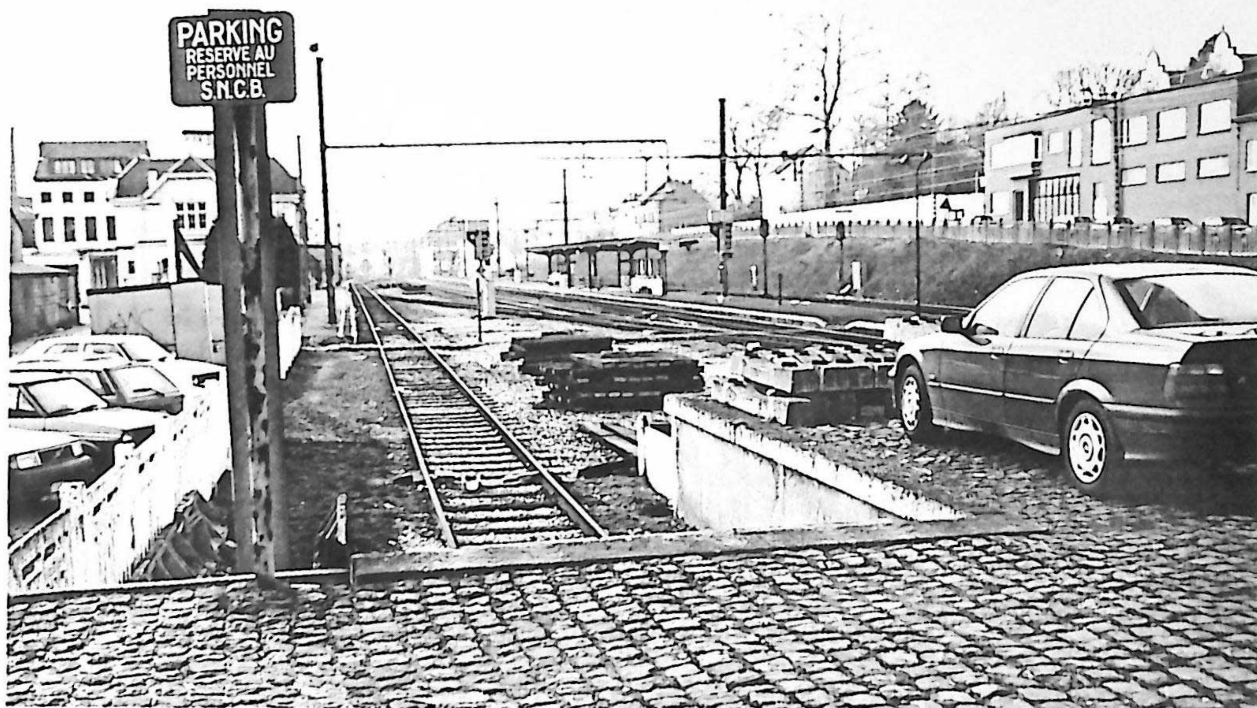
Quai de déchargement vu de la rampe - Gare de Wavre (Photo Marc Pireyn)
